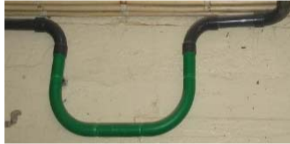
Kuva 16. Näyteilman kondensaatiovesi poistuu tässä putkiston mutkasta
