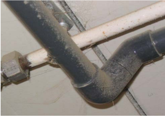
Kuva 8. Putkistoon tehty mutka.
