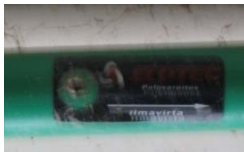
Kuva 20. Putkisto reikien ympärille liimataan tarra tämä helpottaa reikien tukkeutumisen tarkkailua
