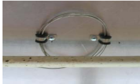
Kuva 13. Kapillaariputken silmukka, taustalla peltilevy
