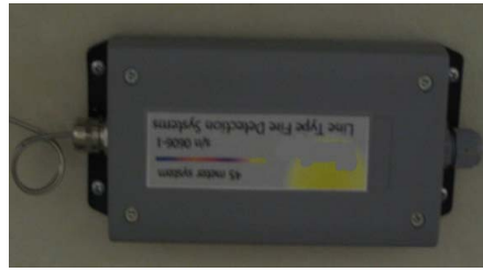
Kuva 12. Kapillaariputki on liitetty tähän ilmaisimeen.
