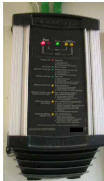
Kuva 22. Laitteiston näytteenottoilmaisin, jossa sijaitsevat toiset suodattimet.
