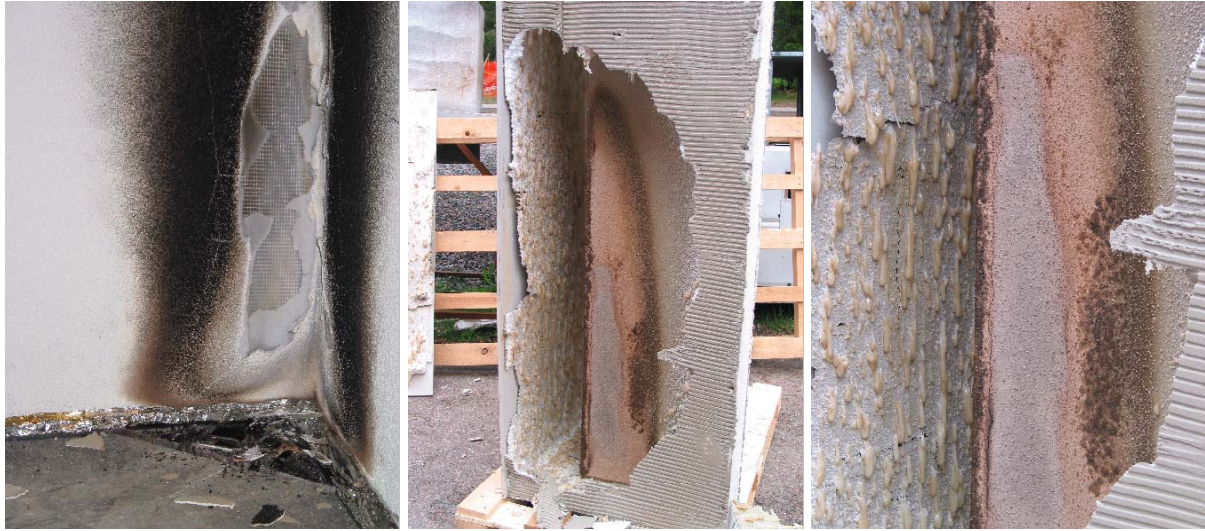
Kuva 1. EPS-ohutrappausrakenteen SBI-kokeen jälkeen. Vasemmalla koekappale edestä: pintarappaus on irronnut, pohjarappaus on edelleen yhtenäinen. Keskellä ja oikealla koekappale takaa: taustalevy on irrotettu kokeen jälkeen.
