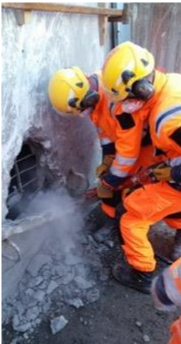
Kuva 9. Teräsbetonin läpäisyä horisontaalisesti ja vertikaalisesti (kuvat läpäisyn koulutusmateriaali, PeO).
