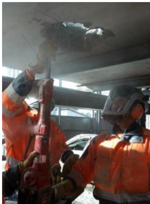
Kuva 9. Teräsbetonin läpäisyä horisontaalisesti ja vertikaalisesti (kuvat läpäisyn koulutusmateriaali, PeO).
