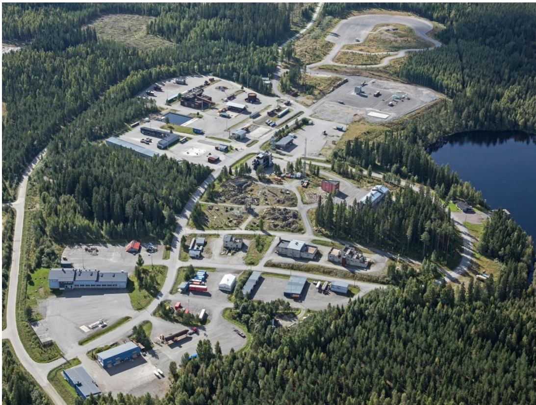
Kuvateksti: Pelastusopiston harjoitusalue, jonne työturvallisuuden harjoitusalue rakentuu.
