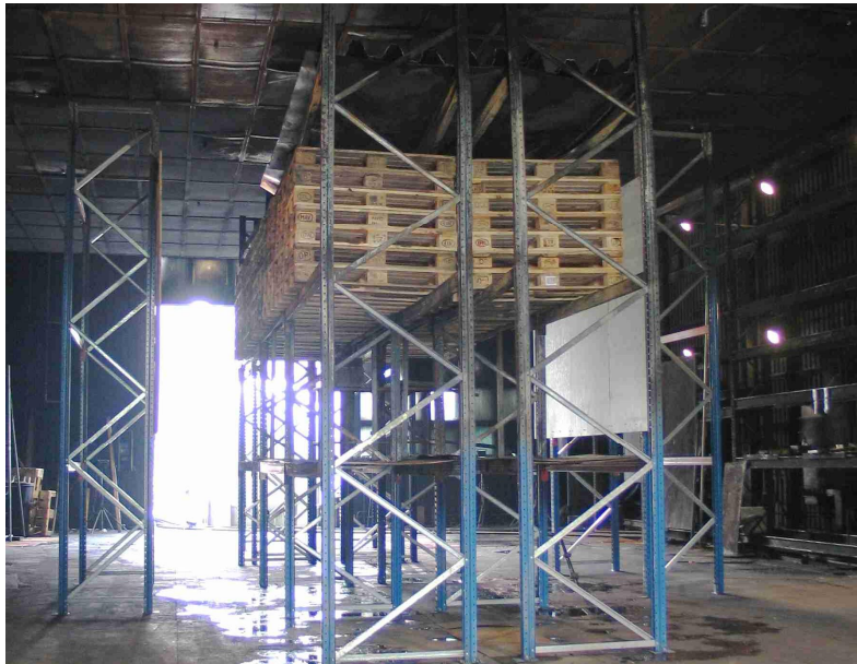
Kuva 1. Rekan perävaunua kuvaava palokuorma.
