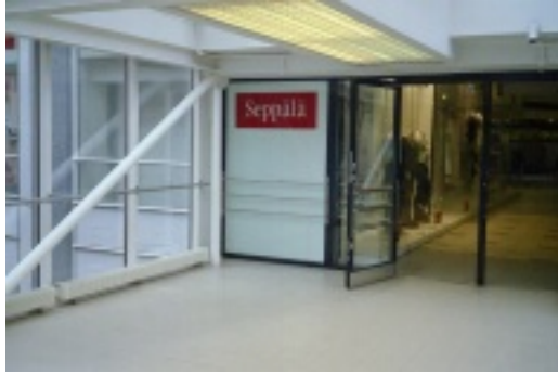
Kuva 1. Lasisia palo-ovia käytetään tyypillisesti käytävissä. Tässä se erottaa kahden rakennuksen välistä yhdyskäytävää toisessa kerroksessa. Tällöin palo-ovia täytyy olla kaksi, kummankin rakennuksen ulkoreunassa. Tällainen palo-ovi on varustettu sulkijalaitteella, joka sulkee oven palon sattuessa.
