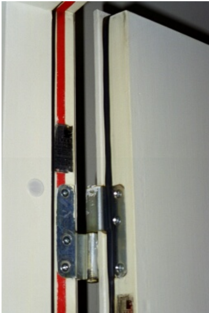
Kuva 4. Tyyppihyväksyntämerkki sijoitetaan oven karmiin ja ovilehteen 1700 mm korkeudelle.
