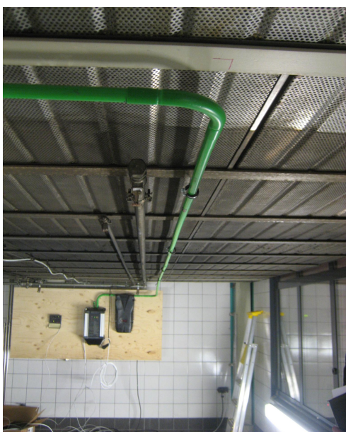
Kuvat 4 ja 5. Palovaroitinjärjestelmiä asennettuina paloteatterissa, Elotec ja Eltek.
